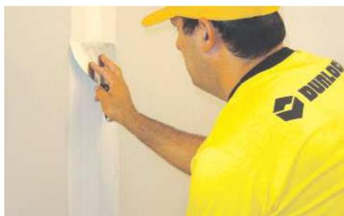
**IMPORTANTE!** : Para que la cinta quede correctamente adherida, se debe realizar este paso en tramos cortos, evitando que la masilla seque demasiado .
